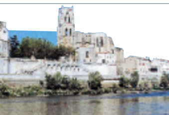
Église St Saturnin - Escalier St Pierre
